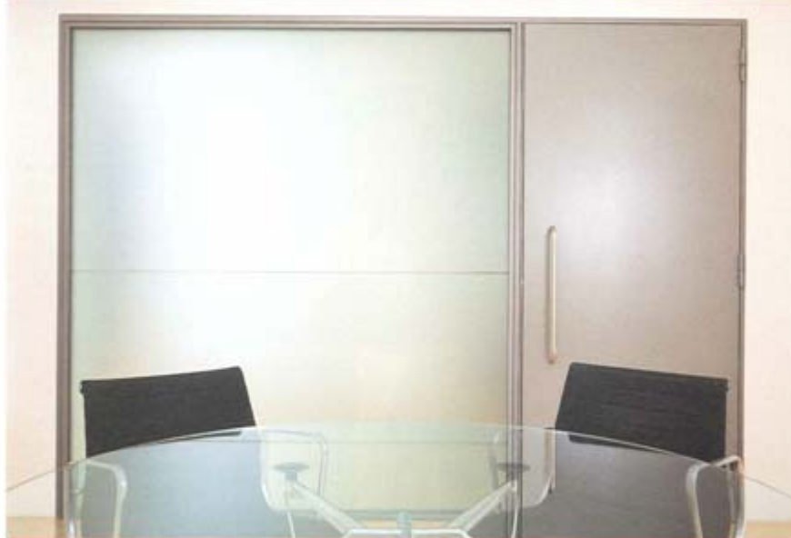
Sala Riunioni piccola. Serramenti interni su disegno con telaio metallico, vetro acidato, porta laccata. Conference room (small). Custom interior doors with metal frames, acid-treated glass and lacquered doors.
