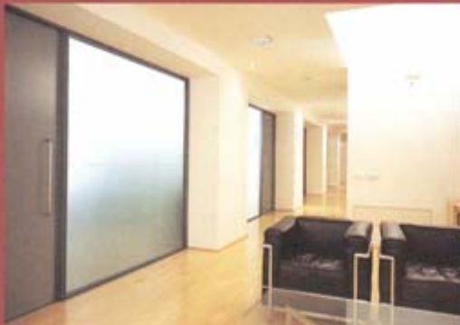
Corridoio Uffici/Attesa Serramenti interni su disegno con telaio metallico, vetro acidato, porta laccata Sedute: Cassina LC1 Corridor to offices/waiting area Custom interior doors with metal frames, acid-treated glass and lacquered doors Seating: LC1 by Cassina
